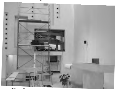
Einbau der Orgel der Firma Kuhn im September 2014, die zu einem grossen Teil durch Spenden finanziert wurde
